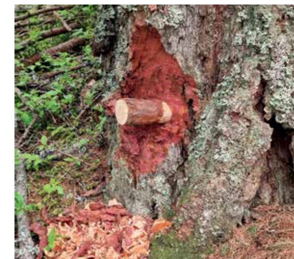
Das Bohrloch muss mit einem Lärchenholz-Stoppel luft- und wasserdicht verschlossen werden.
